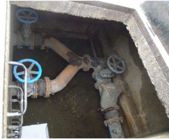
Rácsi végátemelő szerelvényakna
