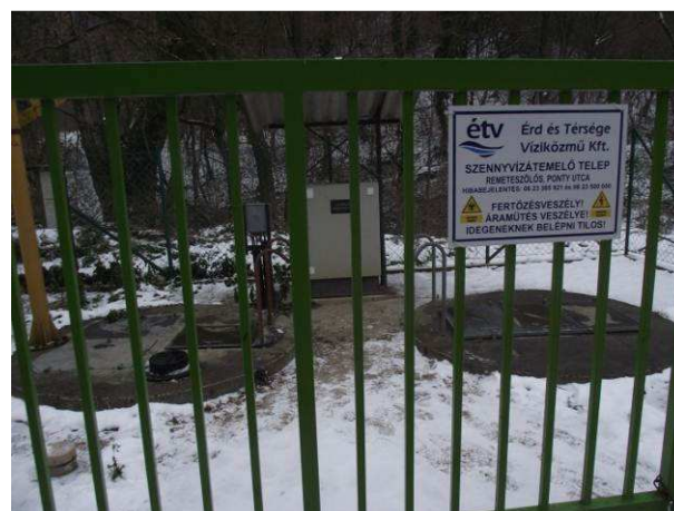
Ponty utcai átemelő akna
