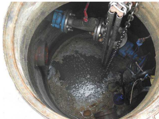
Séta utcai átemelő akna
