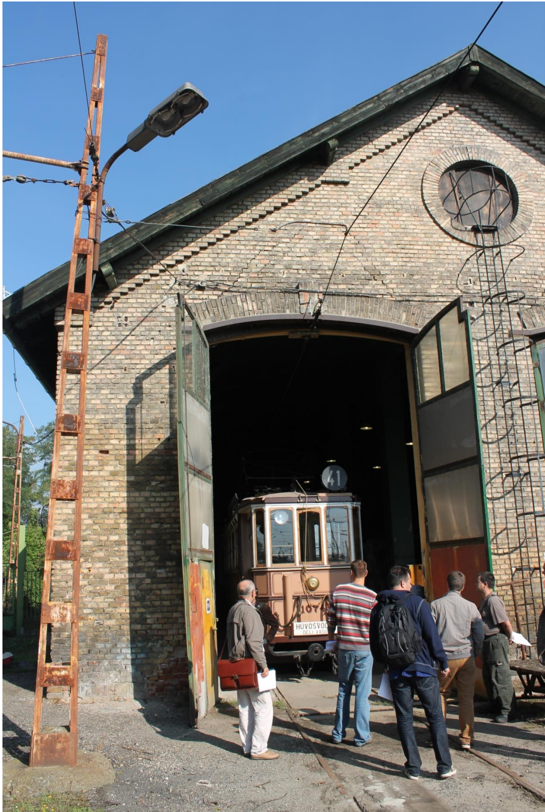
III-es jelű csarnok, bejárati homlokzat
