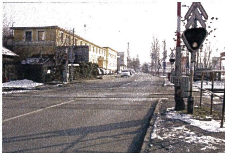
19. ábra: A vasúti átjáró a Puskás Ferenc utca felé
