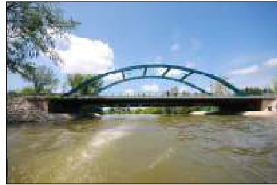
9. ábra: A Halászi településen található Mosoni-Duna híd
