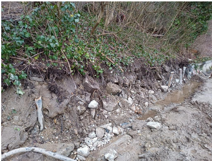
3. ábra: A terület keleti oldalán megtalálható támfal elbontott szakasza
