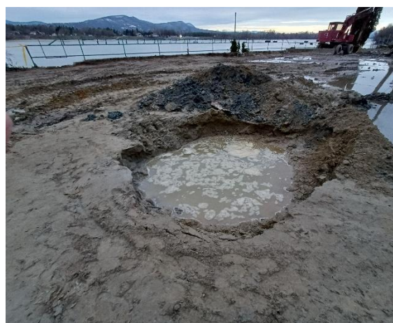
A pontalap helyén (-1,95 méter) a mintavételi pont a vízzel teli munkagödör mellé kiemelt talajtömegeből.
