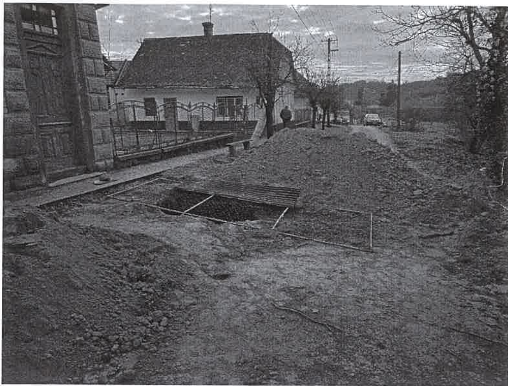
1.kép: A Damjanich u. 5. előtt kb. 2 m átmérőjű kürtővel beszakadt egy feledésbe merült pince a közút alatt. Az utat le kellett zárni. A szakadás körül a terepen nagy méretű horpa-, lefolyástalan terület alakult ki
