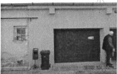
1 sz. épület homlokzat - felújított
