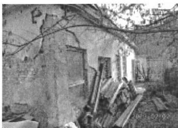
1 sz. épület homlokzat
