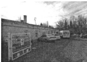
1 sz. épület homlokzat
