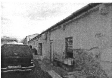
1 sz. épület homlokzat
