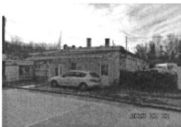
1 sz. épület homlokzat
