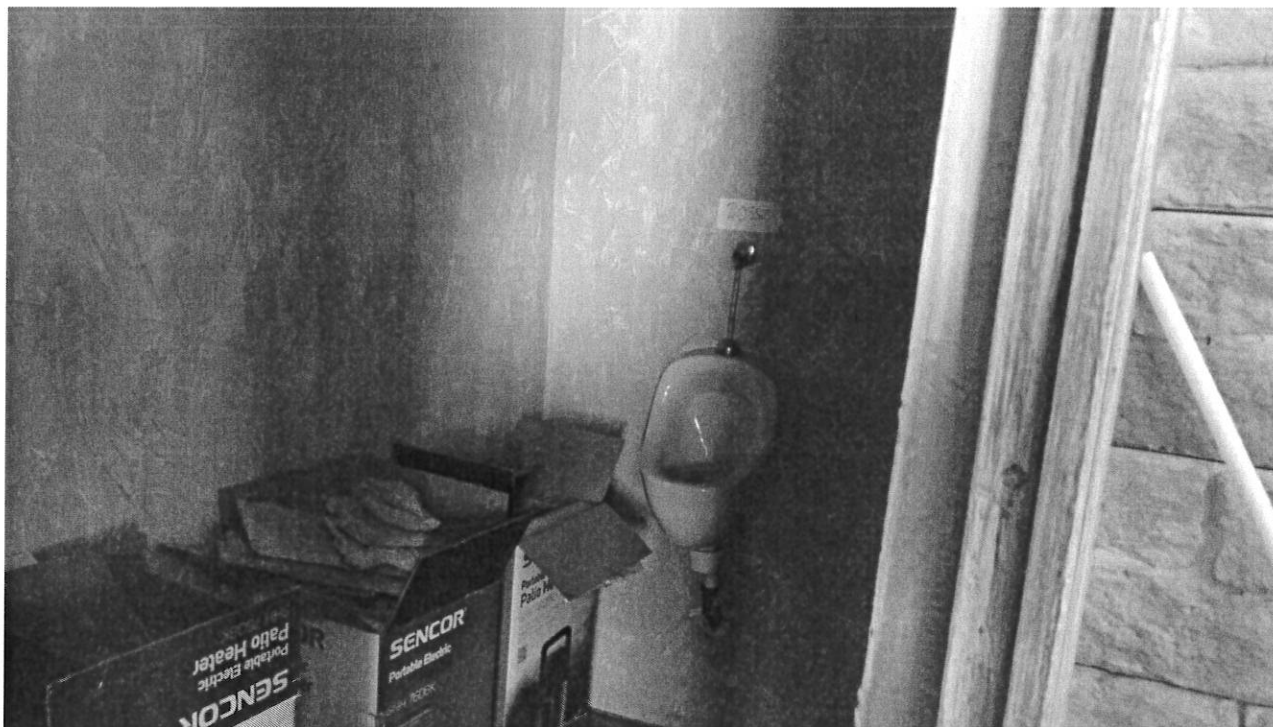
Vizesblokk WC 3.kép
