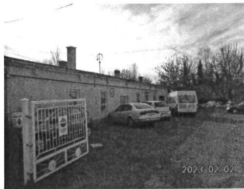
1 sz épület homlokzat
