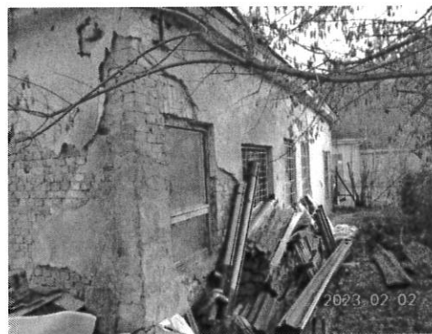
1 sz épület homlokzat
