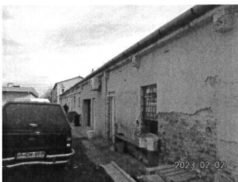
1 sz épület homlokzat
