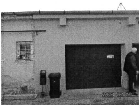
1 sz épület homlokzat - felújított
