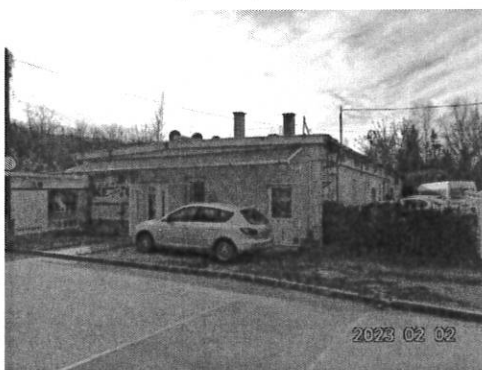
1 sz épület homlokzat
