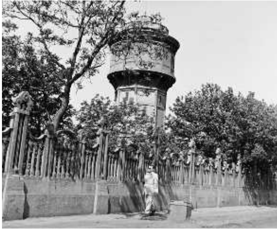
A Kőbányai Víztározó víztornya 1958-ban (forrás: www.fortepan.hu )
