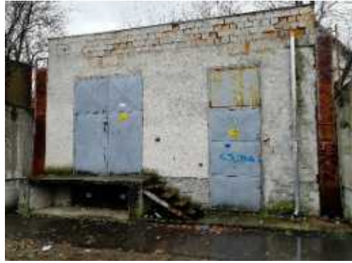
28131/10 építettházias transzformátor 10/0,4 kV-os transzformátor, Bánya utca
