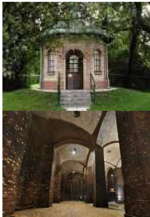
Az Ihász utcai vízműtelepen található vízmedence (kívülről és belülről)
