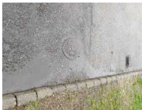
Föld alatti tűzcsap a Halom utcában
