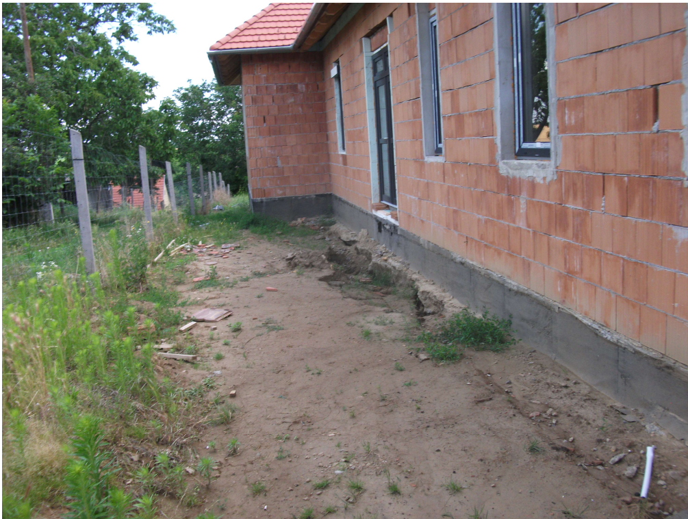
1.kép: A Véméndi Bölcsőde szerkezetkész épülete É-i főfala alatt hosszában szakadt be egy feledésbe merült pince a heves esőzéseket követően . Az építkezést le kellett állítani.
