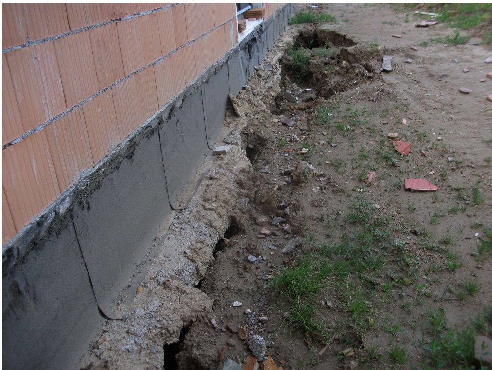
2.kép: A szakadás miatt az épület alapjai kb. 14 m hosszban a levegőben lógnak. Félő, hogy az alap eltörik, az épület belefordul a szakadásba és használhatatlanná válik. Emiatt rendkívül sürgetőek a veszély-elhárítási beavatkozások
