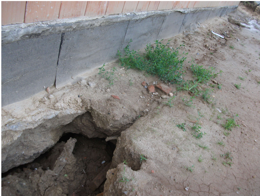
4.kép: Ezen a felvételen látható, hogy kb. 2 m szélességben tátong az üreg, mélysége kb. 0,8-1,2 m és az épület felé tölcésesen tágul. Az is látszik, hogy az épület vége irányába horpa és kimosódás keletkezett. Mielőtt a feltárást megkezdik, az alapokat 3 helyen kiékelte máglya falazattal alá kell dúcolni a betömörített omladék tetejére támasztva.
