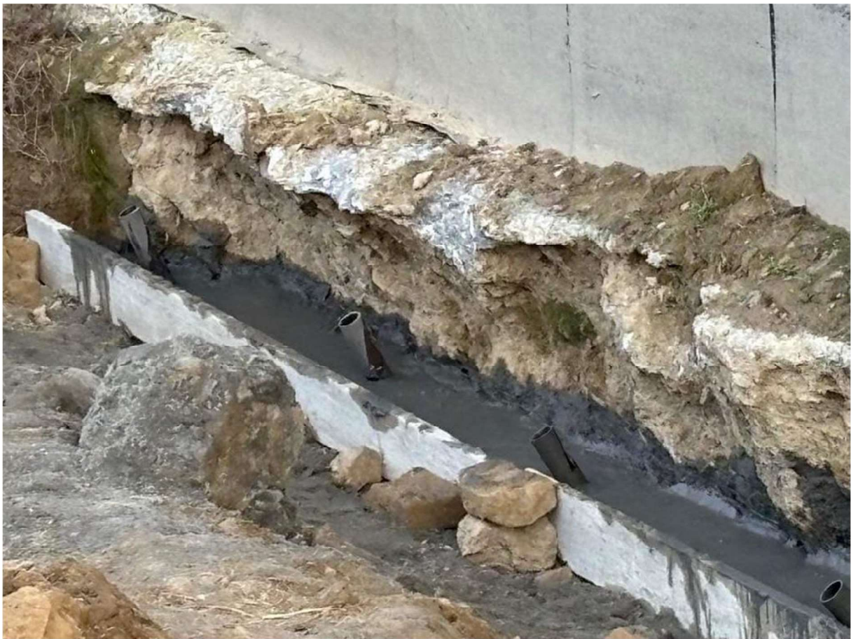
2. Anyagleadó -injektáló furatok készítése.
