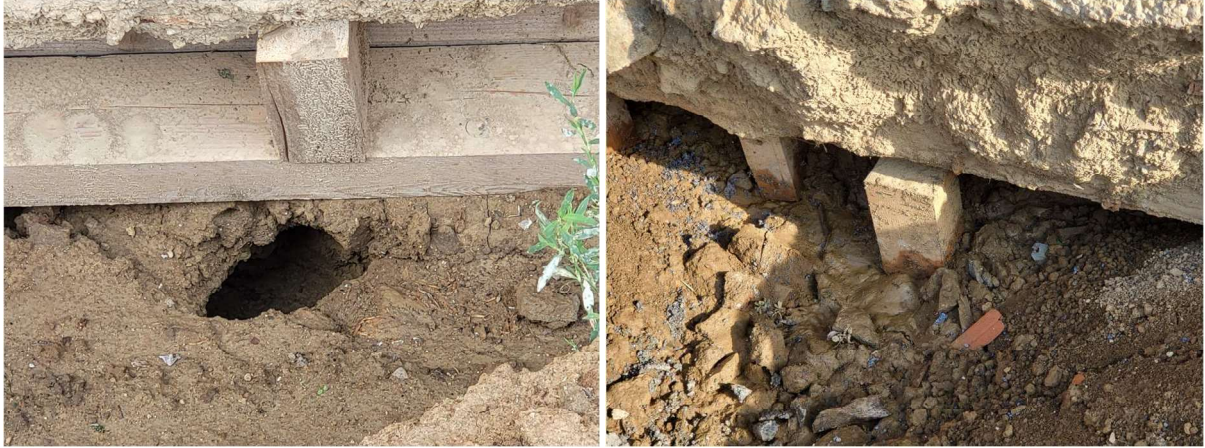
2. Anyagleadó -injektáló furatok készítése.
