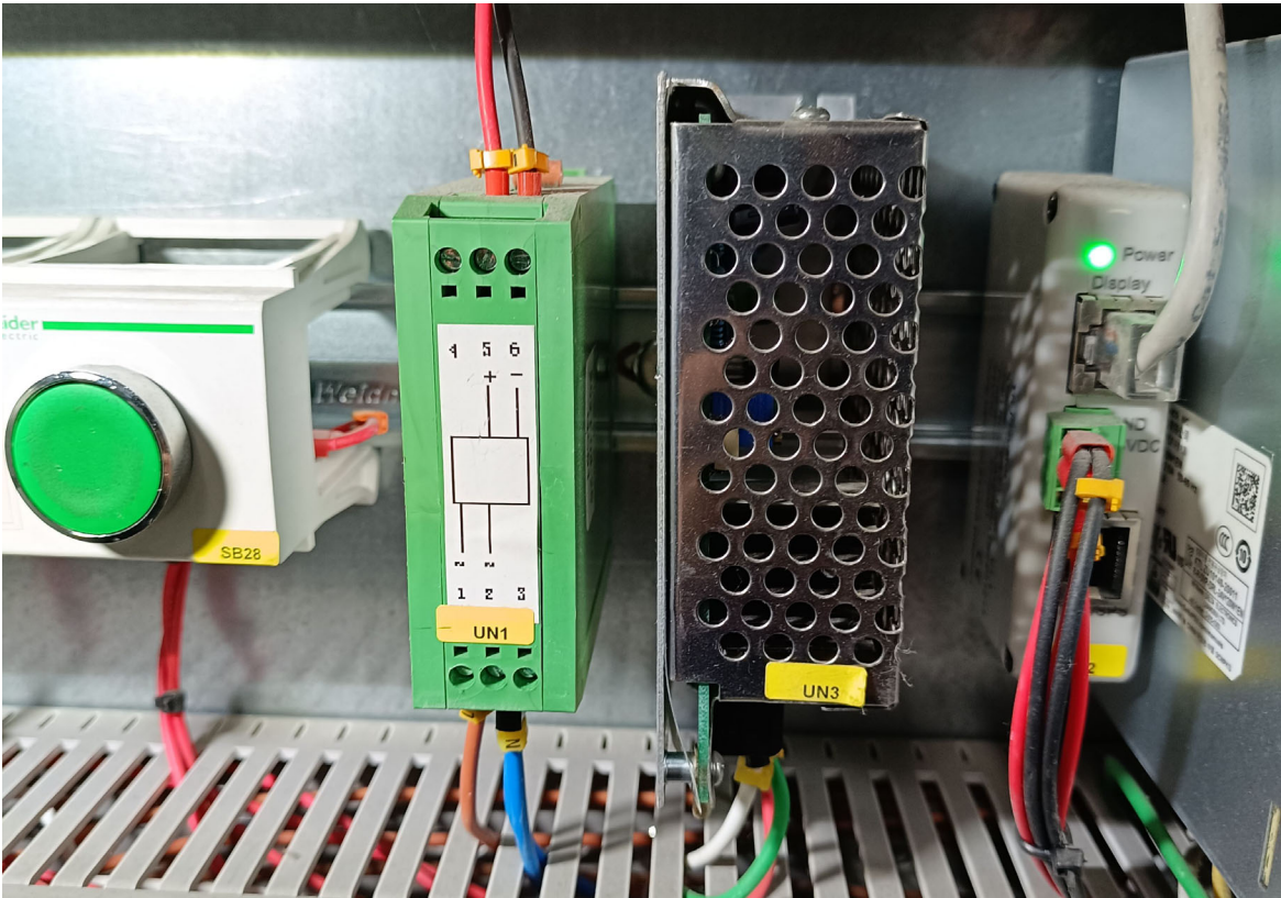
UN3 a kiegészítő féket működtető 198/35VDC tápegység
