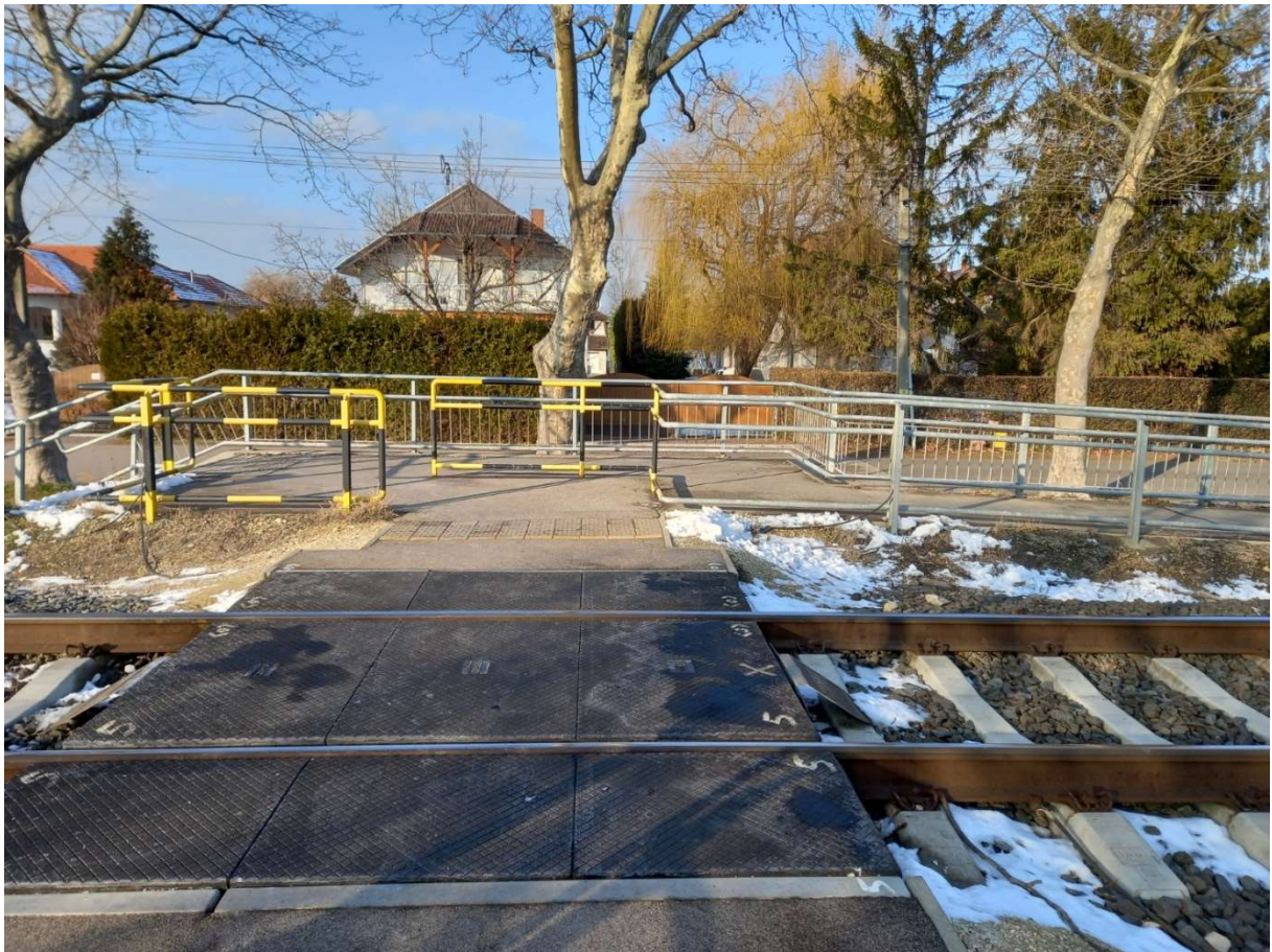
Hűvös közü vasúti átjáró gyalogos vasúti átjáró
