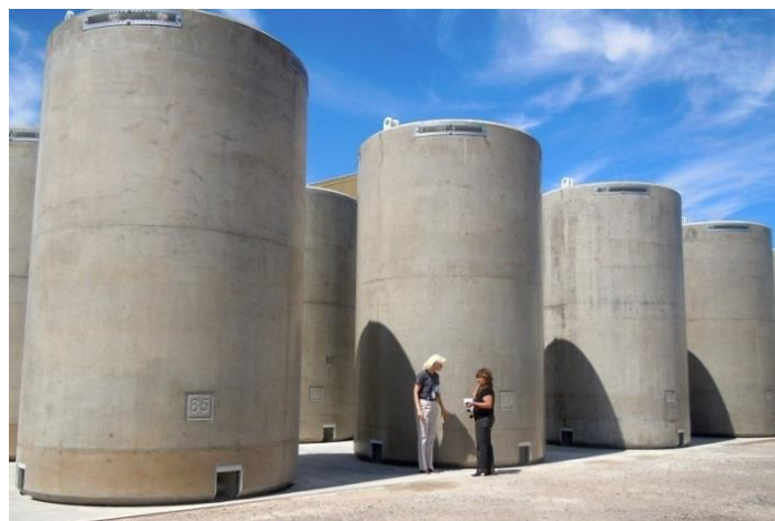
96. ábra: Száraz, konténeres tárolás, függőleges elrendezésben [42]
