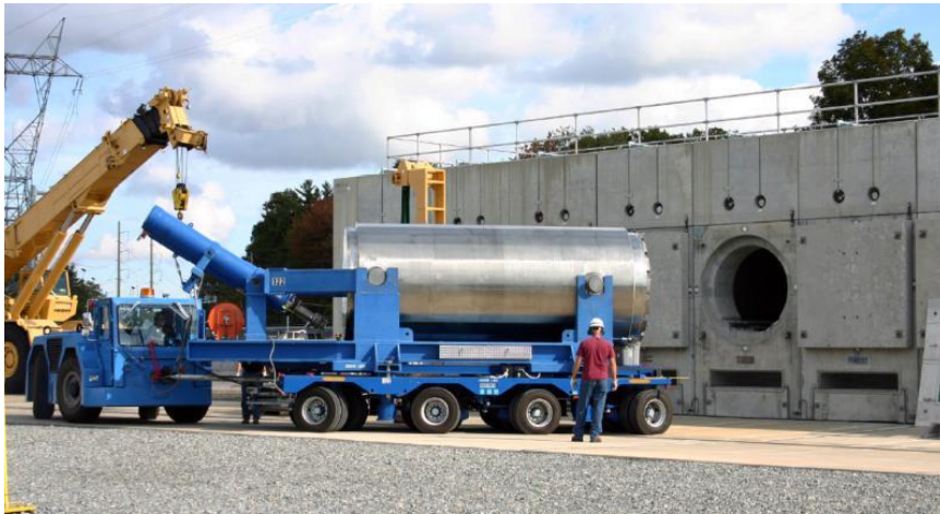
97. ábra: Száraz, vízszintes elrendezésű tároló töltése [43]
