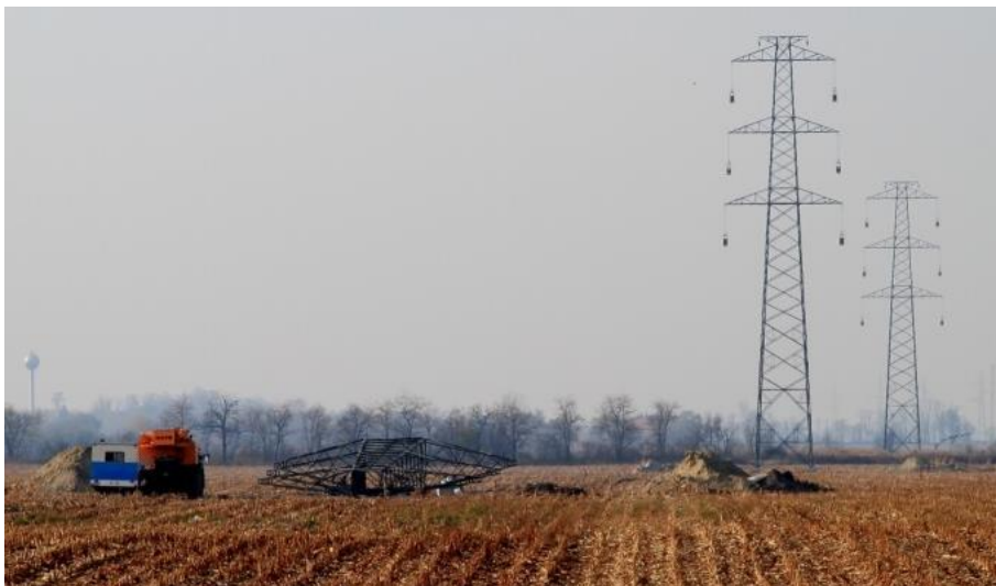
45. ábra: Martonvásár-Győr 400 kV-os szabadvezeték, oszlopszerelés
