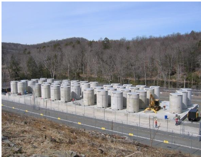
98. ábra: Jellemző elrendezés, száraz konténeres tárolás esetén [44]
