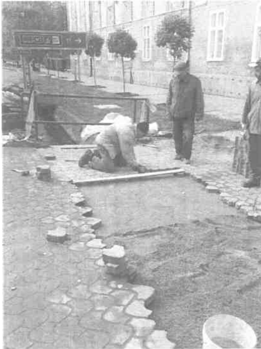
Vízvezető csőcsere utáni díszburkolat javítása,
