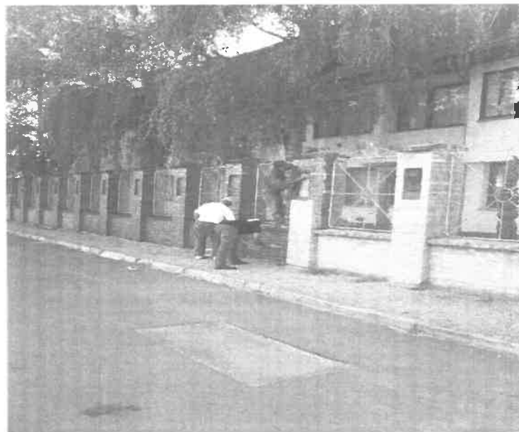
Kerítés állagmegóvása a Tokaji úton
