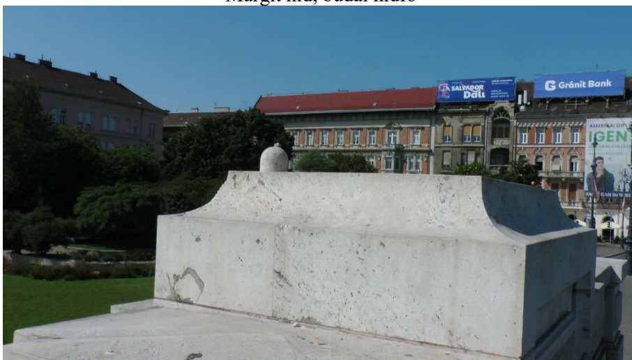
Margit híd, budai hídfő
