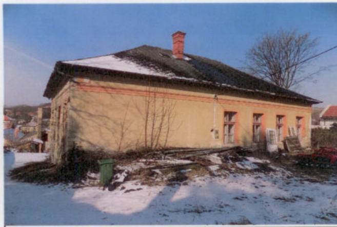
2. épület hátsó homlokzat
