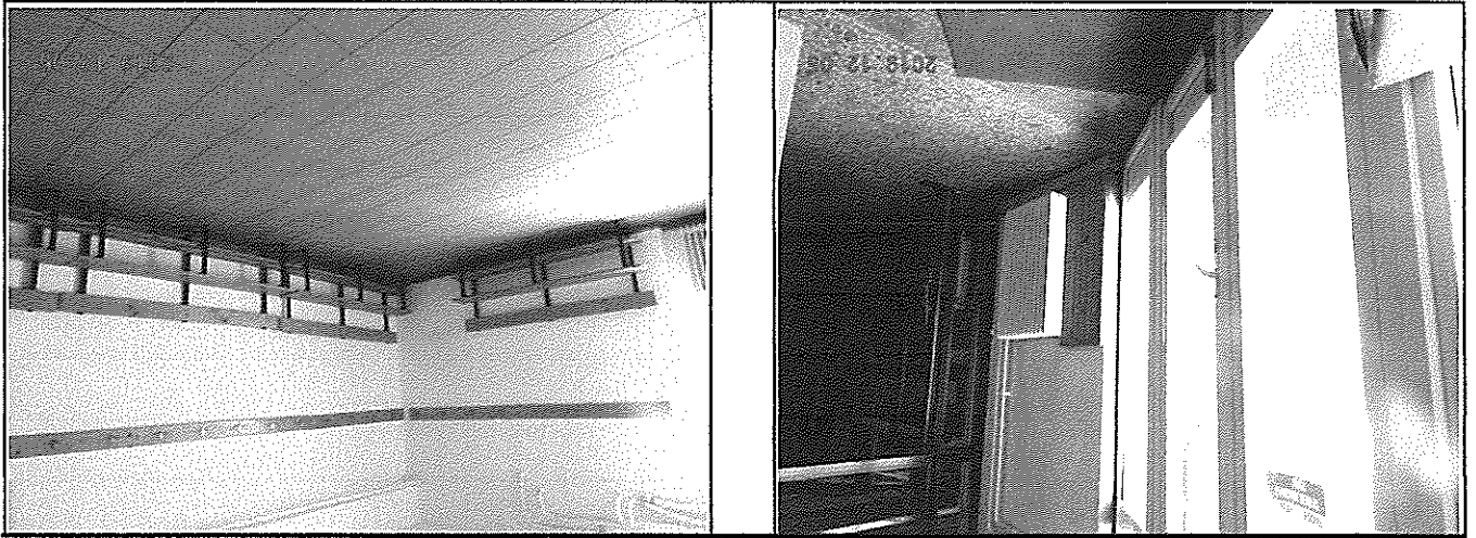
39 Felújított tornatermi női mosdó-zuhanyzó Felújított tornatermi fiú mosdó-zuhanyzó
