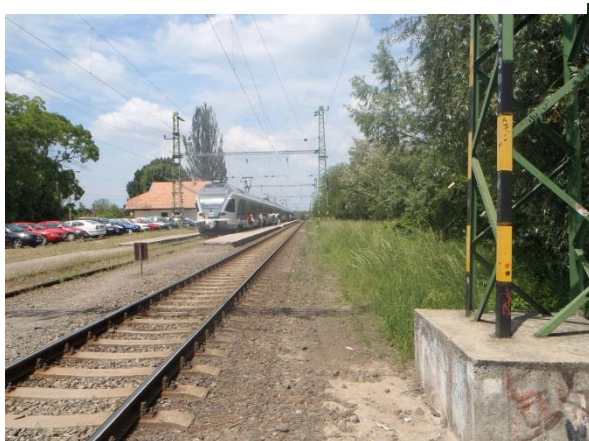
40. Állomásépület és peron délről
