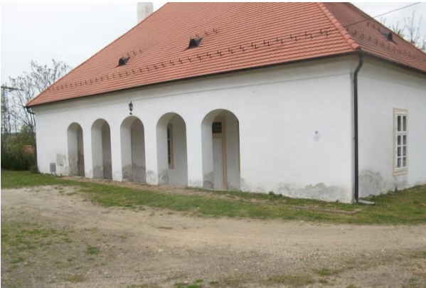
47. Pálos fogadó épülete
