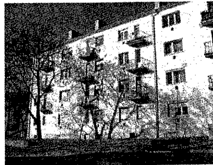
Délkeleti (Béke tér felőli) homlokzat
