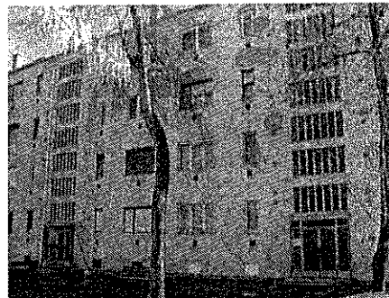
Északnyugati (Május 1 úti) homlokzat
