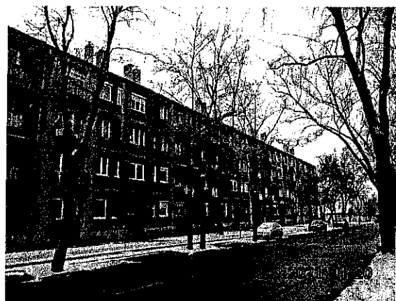
3700 Kazincbarcika, Építők útja 46.2/10.hrsz.: 1136/25/A/90
