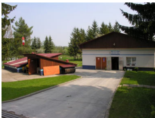
A vízmű épülete
