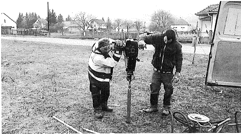
5. kép Fúrás kivitelezése
